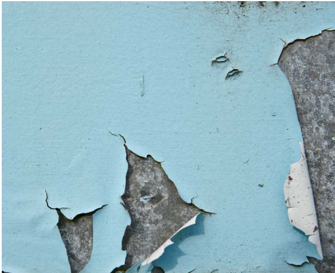
Commencez par contrôler méticuleusement l'état du métal.
