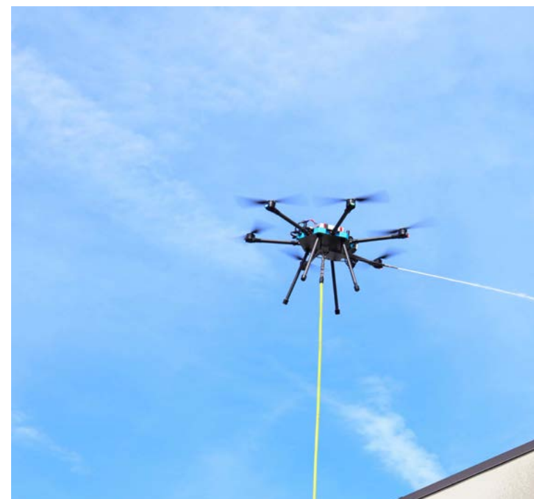
© Lucid Drones - Les drones peuvent également s'utiliser pour les préparatifs (travaux de nettoyage) avant les travaux de peinture.
