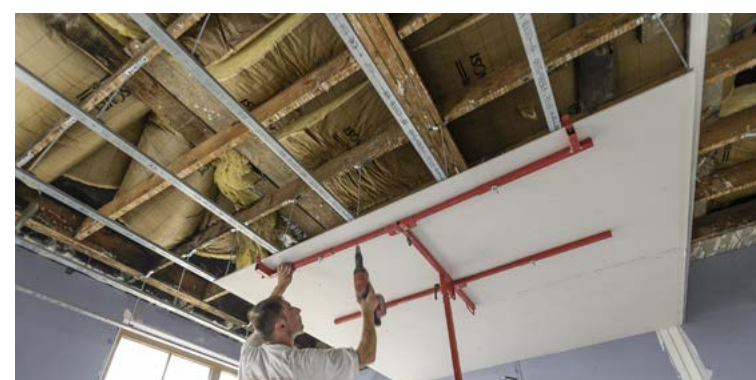
Installation d'un plafond suspendu
