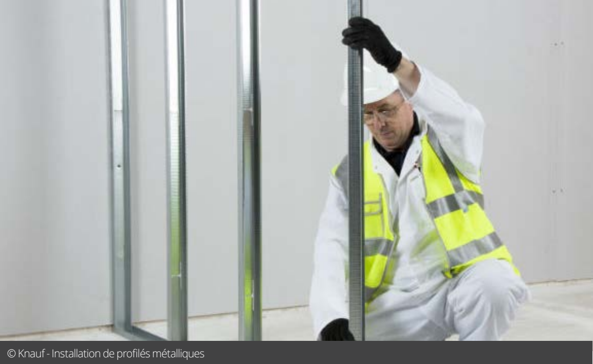
© Knauf - Installation de profilés métalliques
