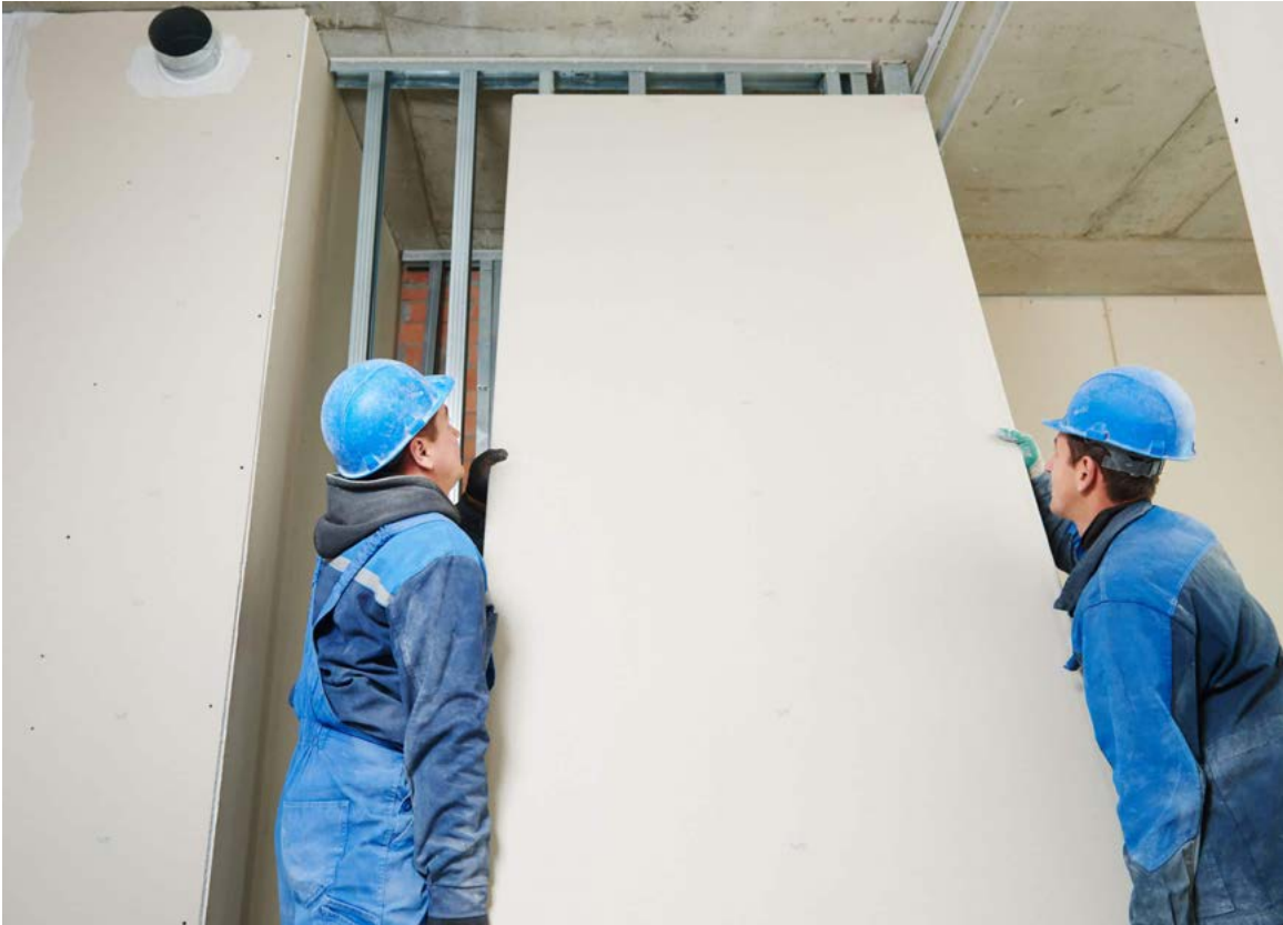
Réalisation d’une cloison acoustique avec des plaques de plâtre
