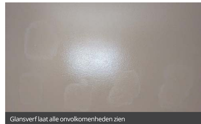
Uitvoeringsgraad III vergt een perfecte ondergrond
