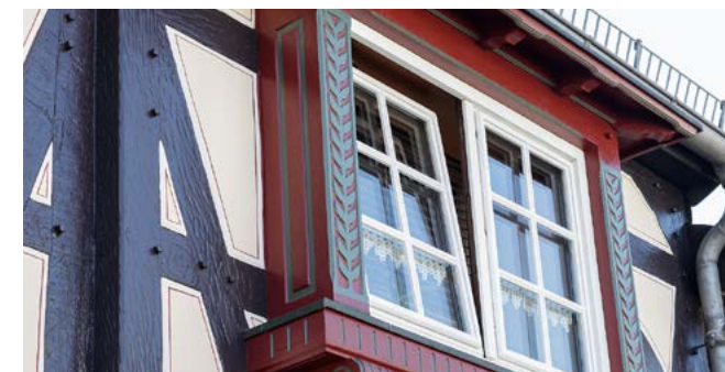
Hoe complexer het vakwerk, hoe welstellender de bewoner destijds was
