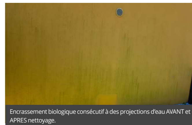
Encrassement biologique consécutif à des projections d'eau AVANT et APRES nettoyage.
