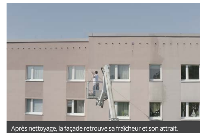
Encrassement biologique consécutif à des projections d'eau AVANT et APRES nettoyage.
