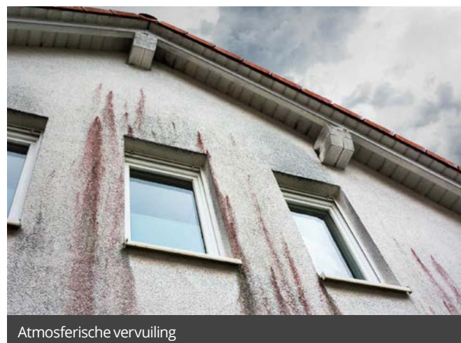
Vervuiling bij bouwaansluitingen
