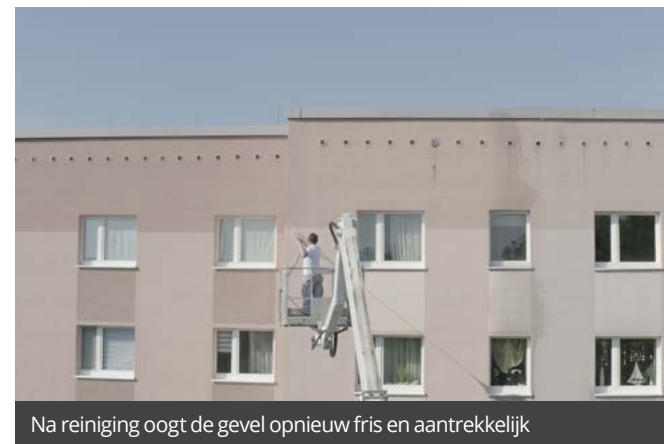
Biologische vervuiling door opspattend water NA reiniging
