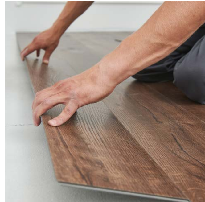
Vinylplanken laten zich zoals laminaat snel en vlot plaatsen
