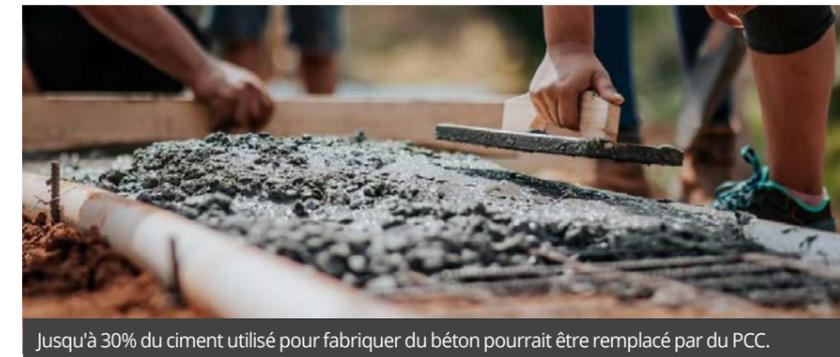
Jusqu'à 30% du ciment utilisé pour fabriquer du béton pourrait être remplacé par du PCC.
