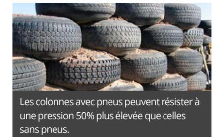
Les colonnes avec pneus peuvent résister à une pression 50% plus élevée que celles sans pneus.
