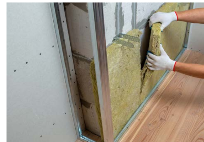
Wanneer de spouw gevuld wordt met soepel absorberend materiaal (bv. rotswol) kan een hogere geluidisolatie gerealiseerd worden
