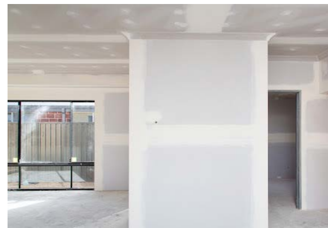
GTEK - Qua geluid speelt vooral de massa van de platen een rol: 'hoe zwaarder, hoe beter'
