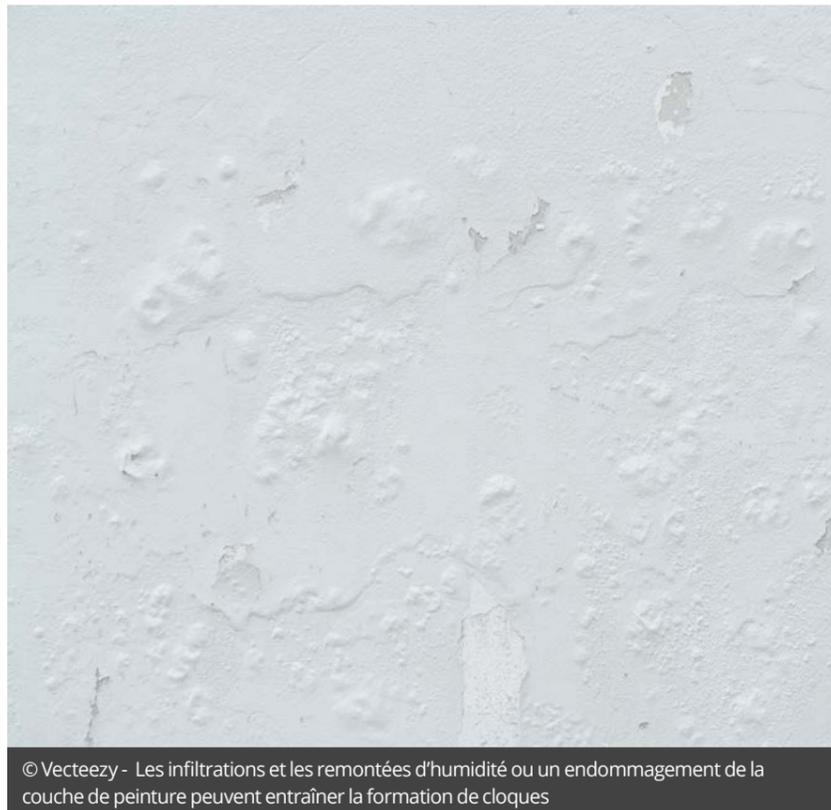
© Vecteezy - Les infiltrations et les remontées d'humidité ou un endommagement de la couche de peinture peuvent entraîner la formation de cloques
